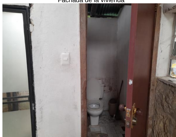
Unidad sanitaria de la vivienda
