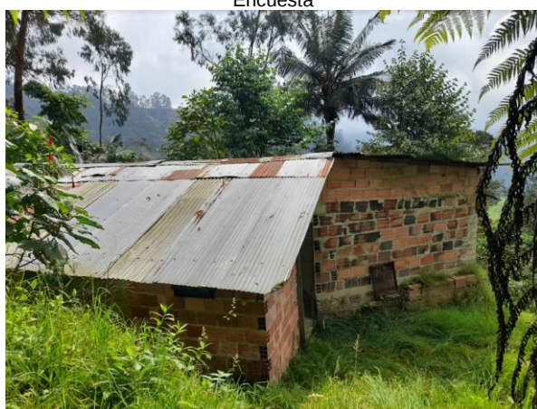
Techos y paredes de la vivienda
