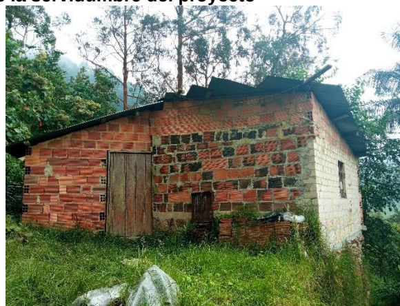
Fachada de la vivienda
