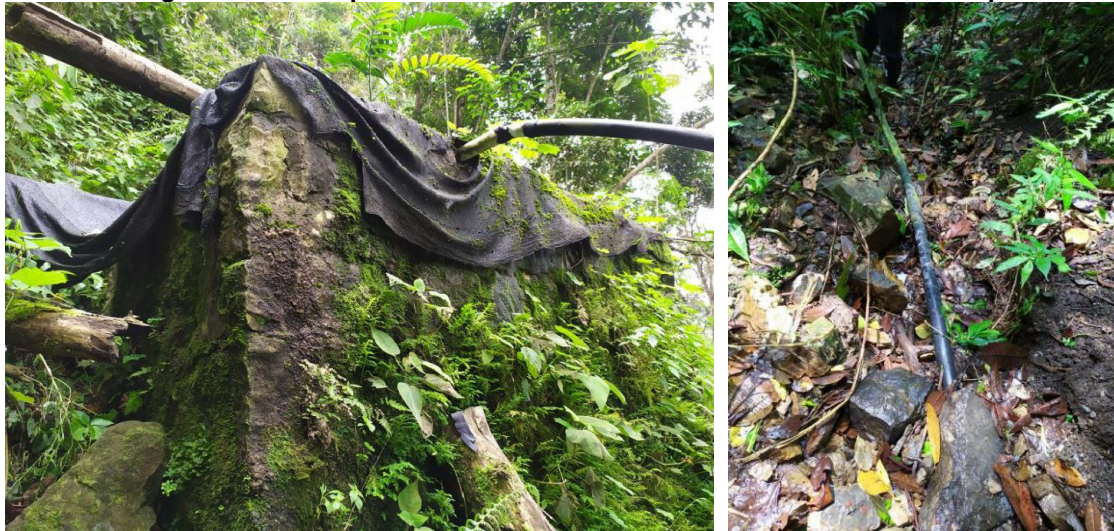
Fotografía 5-7. Tanque de almacenamiento comunitario Vereda Chicaque
