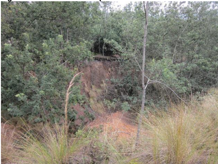
Fotografía 5-1 Torre 447N – (X: 4889033.093 – Y: 2000067.555)
