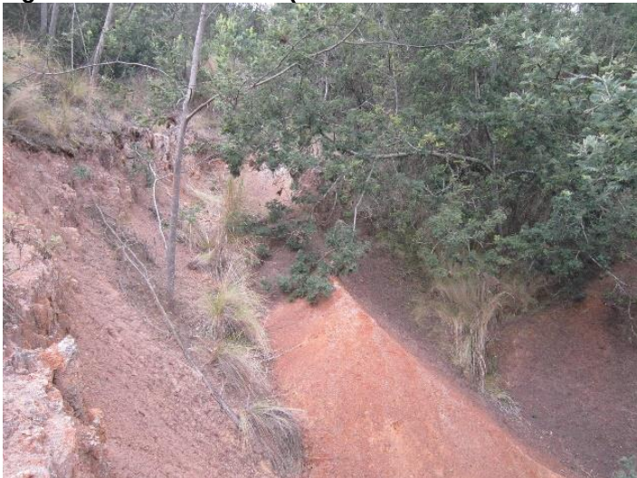
Fotografía 5-2 Torre 447N – (X: 4889033.093 – Y: 2000067.555)
