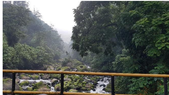
Fotografía 5-11 Depósitos de bloques cauce del Río Bogotá – Acceso Nueva Esperanza Coordenadas CTM-12 X: 4857182,22 Y: 2062482,12
